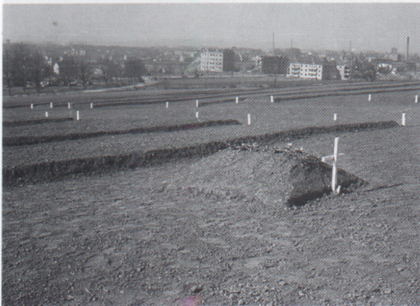
Links: Als der Signal-Corps-Fotograf Zwick dieses Bild am 18. April aufnahm, waren die Massengräber bereits eingeebnet. Der Blick geht nach Süden in Richtung Boelcke-Kaserne (im Hintergrund links nicht zu erkennen). Die Hauptstraße in der Bildmitte ist die Hallesche
