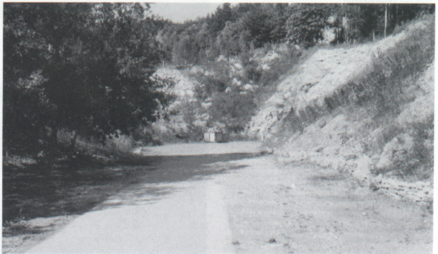
Nach der Sprengung durch die Sowjetarmee 1948 sieht der Südeingang von Fahrstollen B heute so aus.
